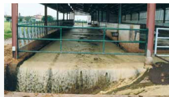
Wiederverwertung von separierter Dünngülle für das Spülsystem
