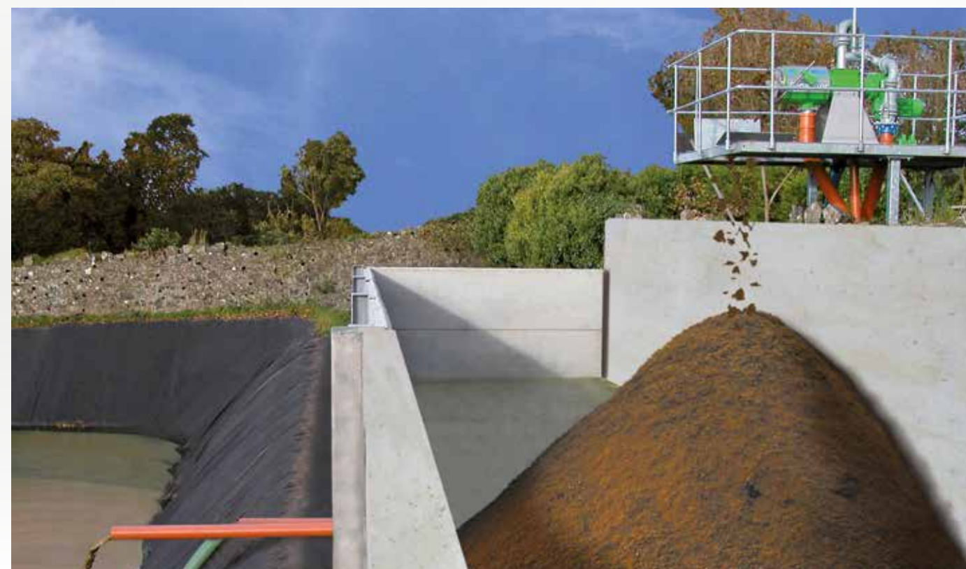
Wiederverwertung von separierter Dünngülle für das Spülsystem
