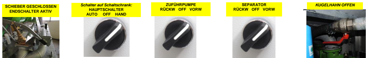
Abbildung 20 Hebel und Schalterstellung im Handbetrieb mit Ablaufpumpe
