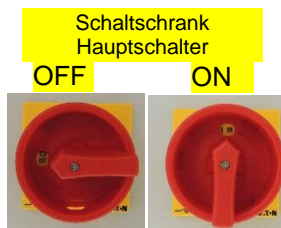
Abbildung 23 Schaltschrank Hauptschalter
