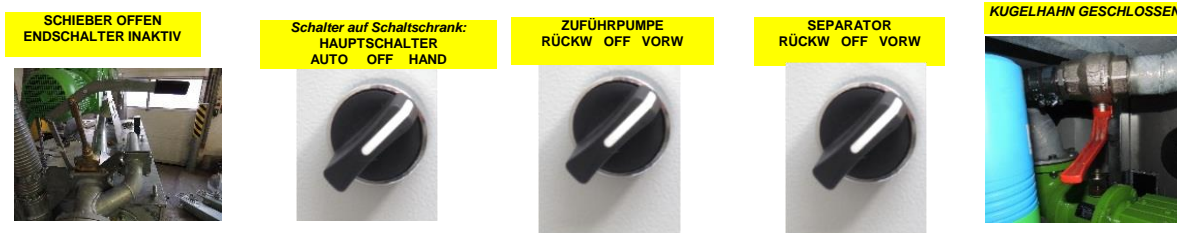
Abbildung 21 Hebel und Schalterstellung im Handbetrieb ohne Ablaufpumpe
