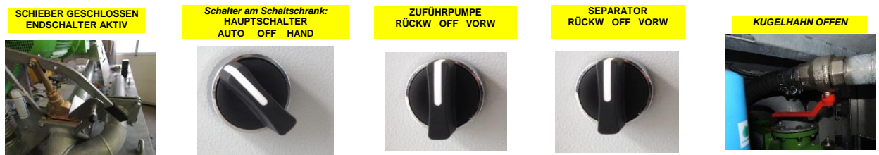
Abbildung 18 Hebel und Schalterstellung im Automatikbetrieb mit Ablaufpumpe
