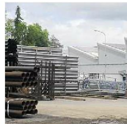
Alles neu: Fassaden, Wärmedämmung
