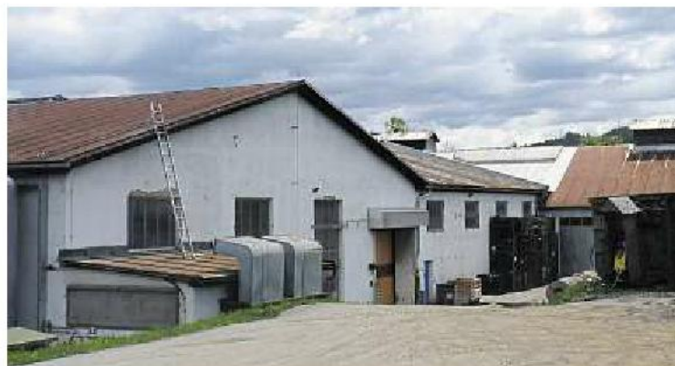
Ein Teil der noch nicht sanierten Gebäude der Bauer Group in Voitsberg
