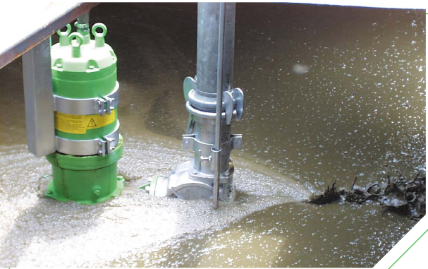
BESCHICKUNG DER ANLAGE MIT EINER SPEZIELLEN TAUCHMOTORSCHNEIDPUMPE
