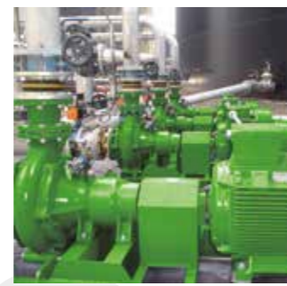
MAGNUM SX Dickstoffpumpe Getriebe- und Lagerstuhlausführung
