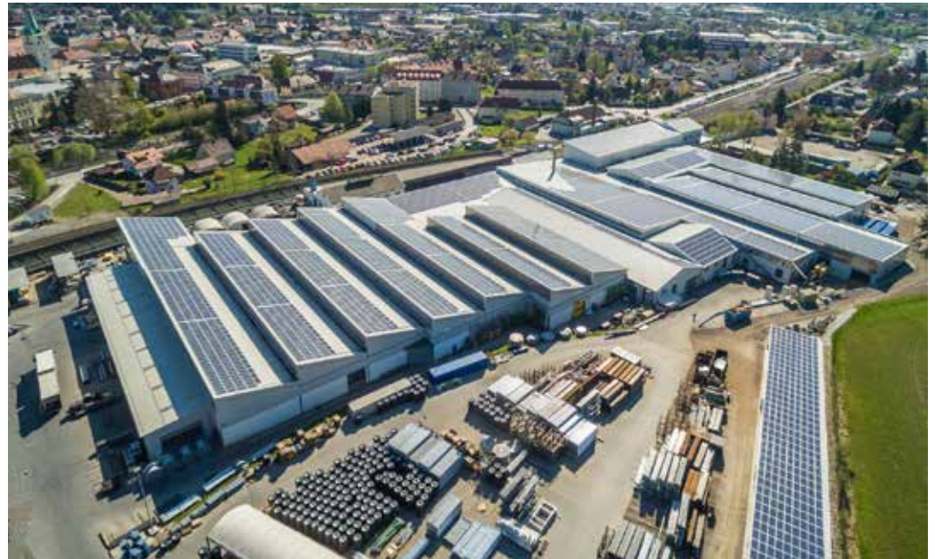
Sede central de BAUER en Austria
